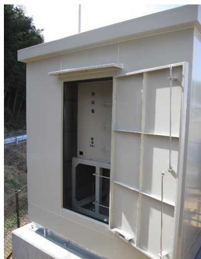
燃料タンクの設置
