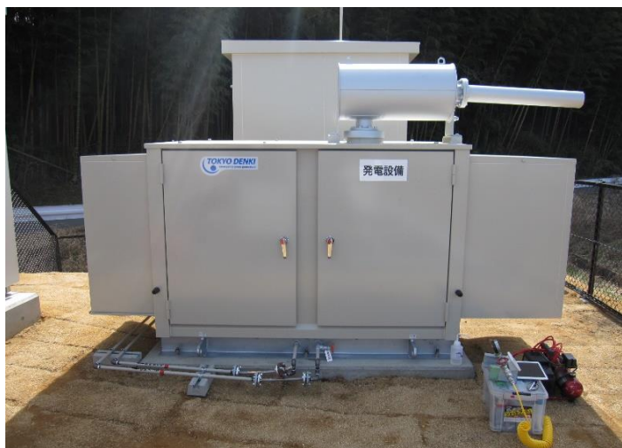
非常用電源設備の設置
