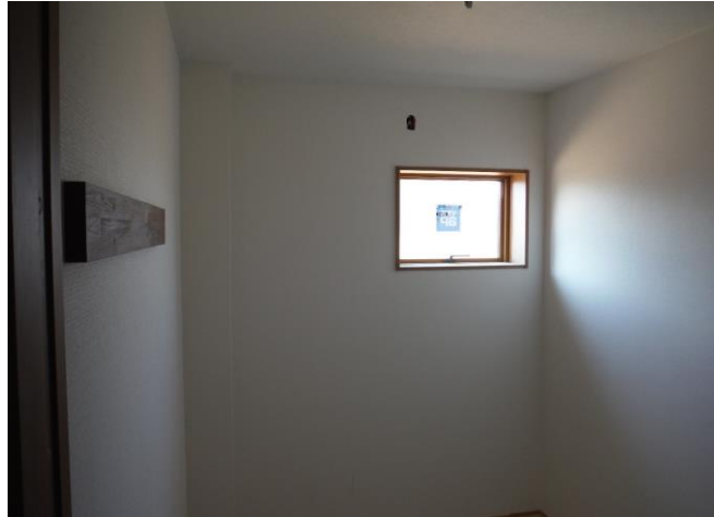
仮眠室の内装工事状況口
